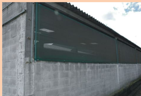
Malla cortaventos nun lateral completamente aberto e noutro con parte de parede de bloque de formigón.
