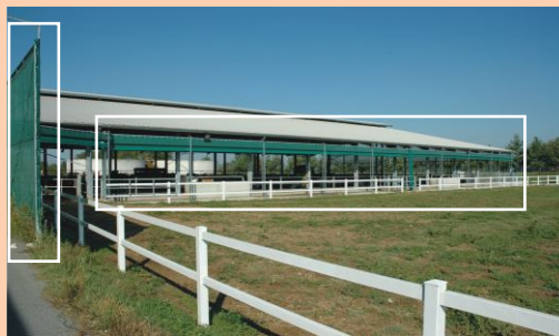
Exemplo de lateral con cortina e malla cortaventos.
