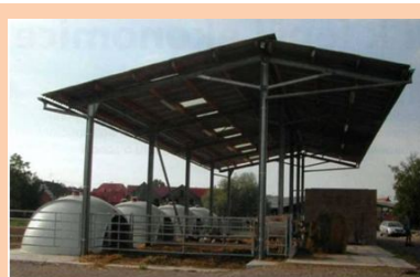
Ringleira de casetas cunha edificación cubrindo os currais dianteiros e o corredor de alimentación/servizo.
