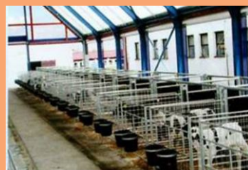
O cerramento lateral permite pechalo ou abri-lo a vontade.
