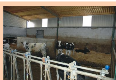
Corte con muro entre a zona de cama e o corredor de acceso ao presebe.
