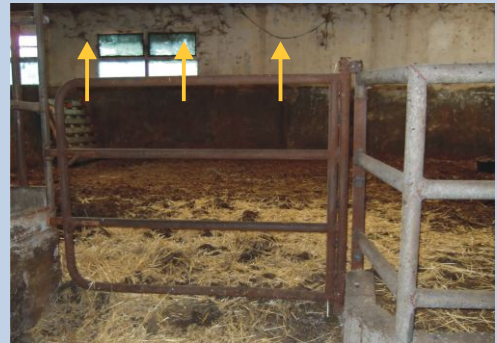
Corte mal ventilada con arañeiras.
